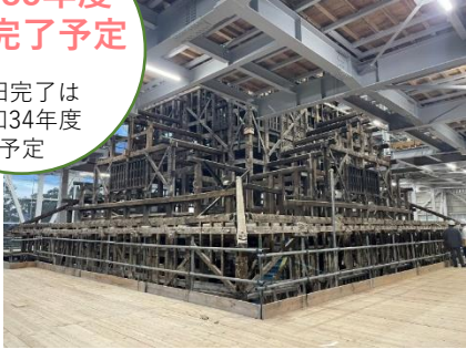
宇土櫓解体工事の様子
