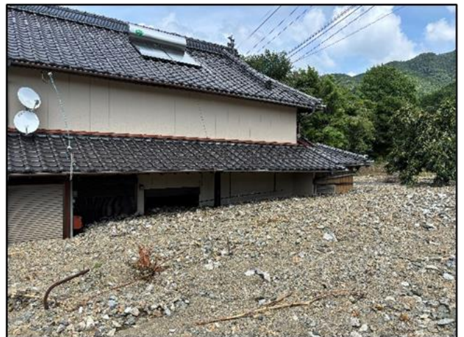
八代市の宅地内土砂堆積の状況
