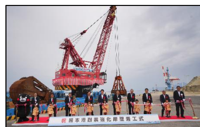
【耐震強化岸壁着工式 R6.6.8】
