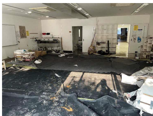
【熊本中央高等学校：校舎地下（書道室）】
