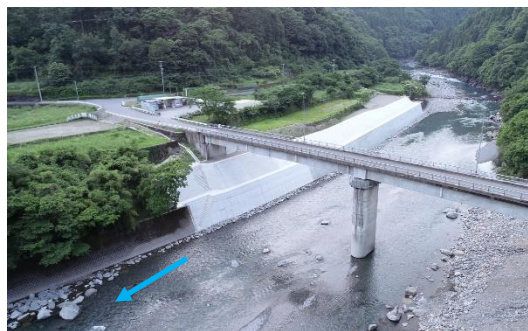
復旧状況（令和7年7月完了）
