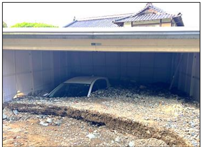
八代市の宅地内土砂堆積の状況
