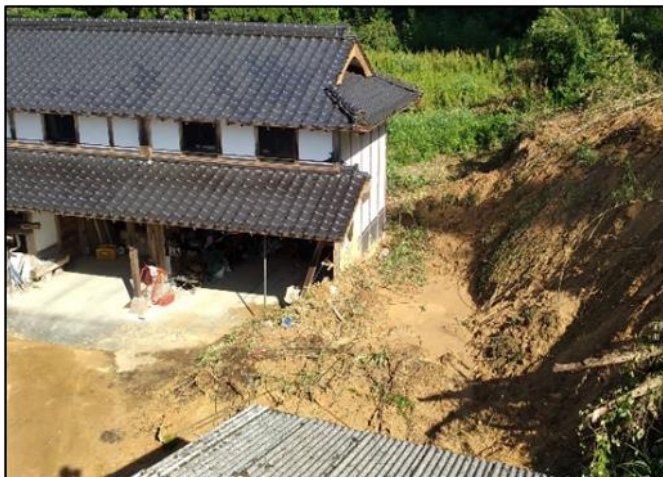
美里町の宅地内土砂堆積の状況
