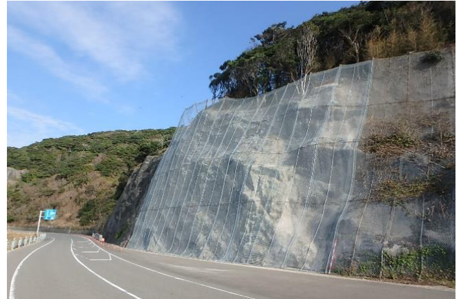
国道389号（天草市）落石防護網工
