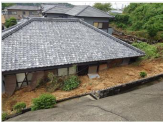
上天草市の宅地内土砂堆積の状況
