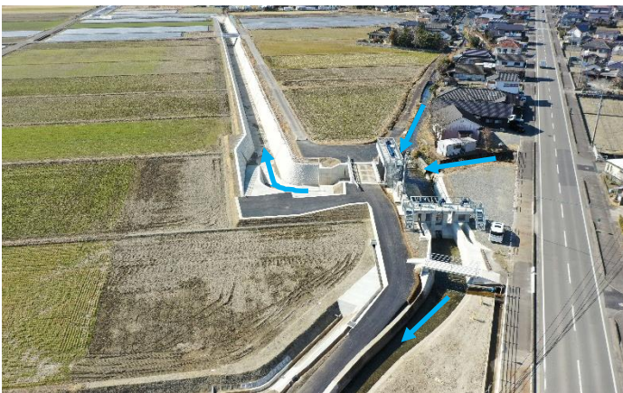
御溝川（人吉市）二次放水路整備
