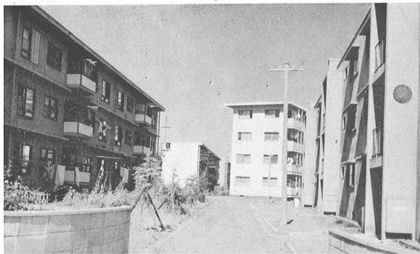
↓ 建ちならぶアパート群、中庭の緑化も日をおつて……
