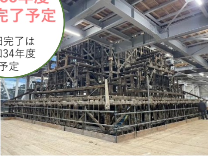
宇土櫓解体工事の様子
