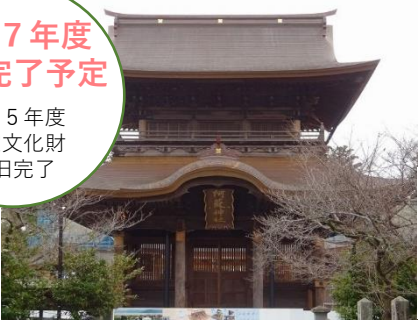
復旧した阿蘇神社楼門
