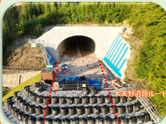
覆工コンクリート完成
