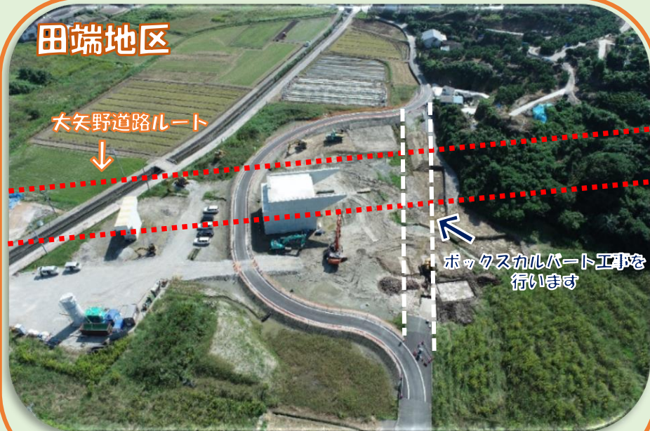
ボックスカルバート工事を行うため、市道を付け替えました
