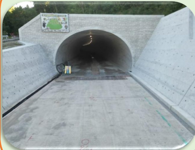
覆工コンクリート完成
