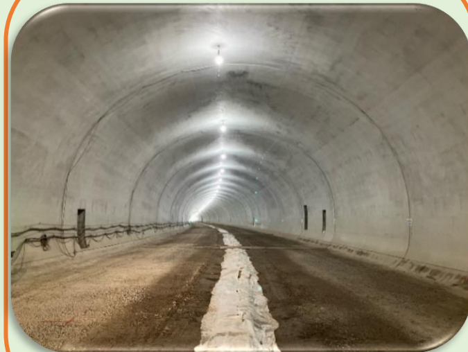
現在のトンネル内部
