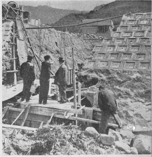
土地改良工事はすゝむ(取水口の工事)
