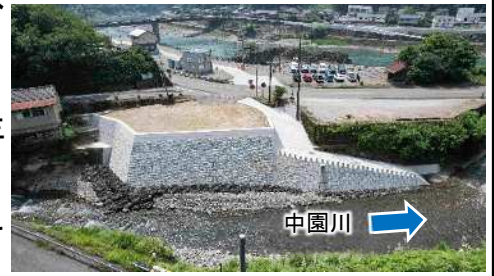
6月 中園川宅地かさ上げ完了（球磨村）
