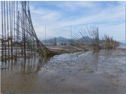
あさり・ハマグリ保護区の柵の 破損等 【緑川河口】
