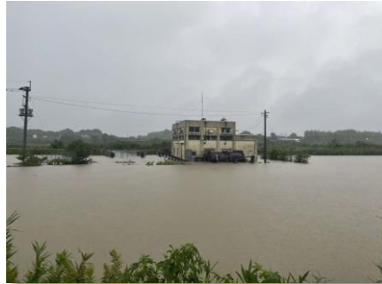
農地及び排水機場冠水 【玉名市大浜町】
