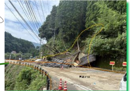
山腹崩壊 【美里町豊福肉伏】
