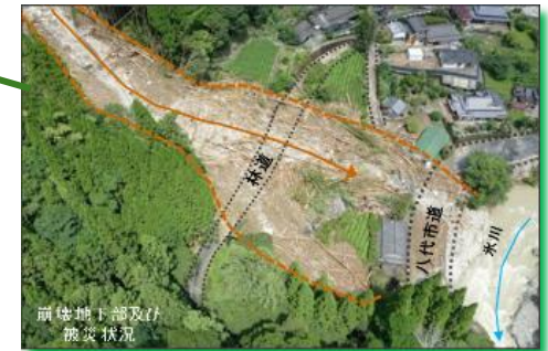
山腹崩壊 【八代市泉町下岳古屋敷】
