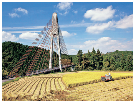
鮎の瀬大橋開通 (H11.8.4)
