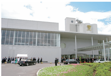
サントリー(株)九州熊本工場竣工（H15.7.11） 〈写真提供：サントリー(株)〉
