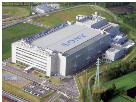
ソニーセミコンダクタ九州(株) 熊本テクノロジーセンター稼働開始 (H13.10.1) 〈写真提供：ソニーセミコンダクタ マニュファクチャリング(株)〉
