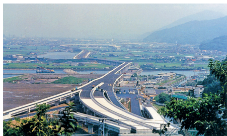
南九州西回り自動車道 八代南IC一日奈久IC間開通 (H13.10.6)
