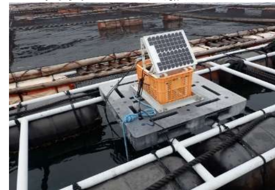
自動水質監視テレメーター（楠浦湾）
