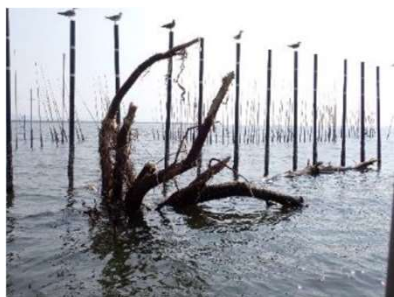
漂流物対策フェンス(白川河口)
