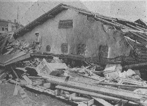
一瞬のうちに山上茶屋は崩れた
