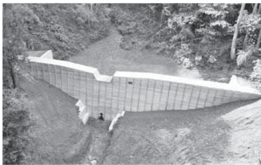
溪間工（谷止工）
