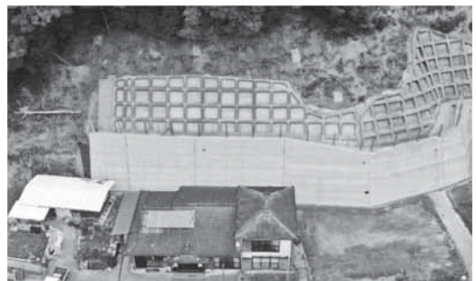
急傾斜地崩壊対策（山口地区：芦北町）
