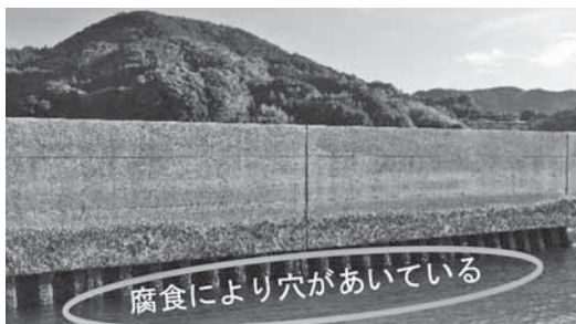
機能保全工事の実施【着工前】
