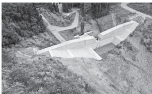
砂防（上初野川砂防えん堤：水俣市）
