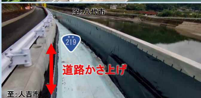
坂本地区の工事状況
