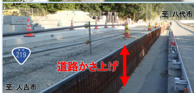
瀬高地区の工事状況
