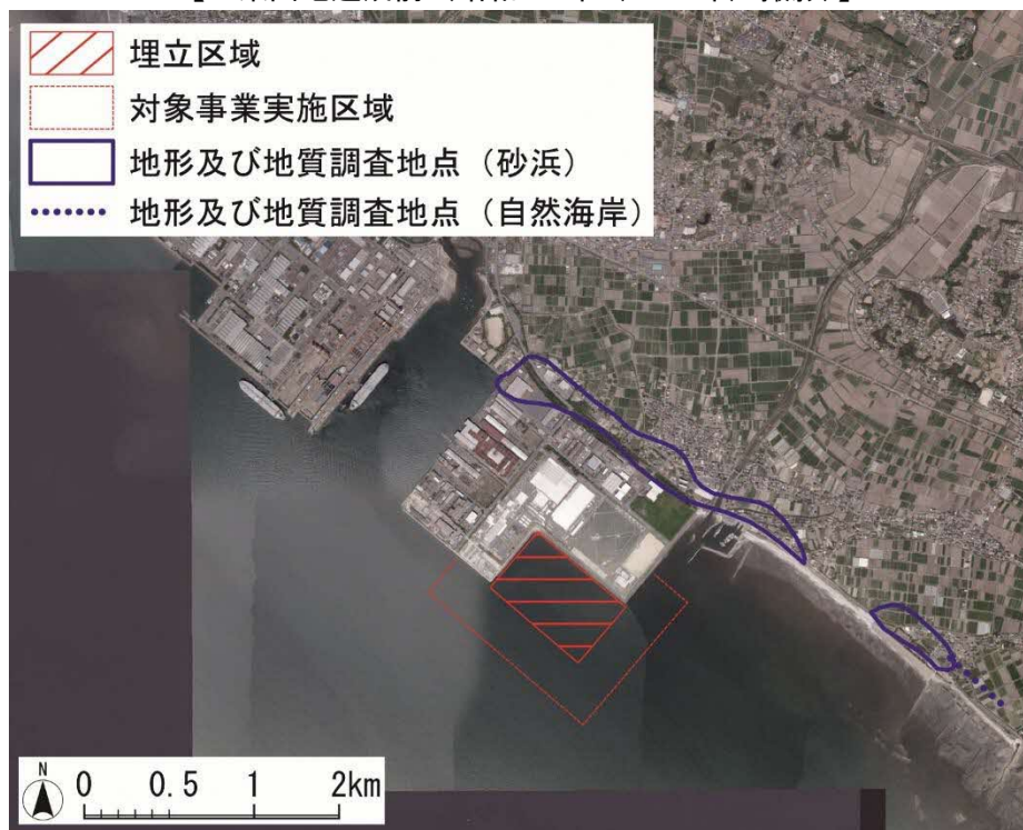
【工業団地造成後（平成 30 年（2018 年）撮影）】
