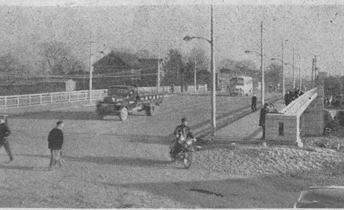
十一月から工事をはじめています。道巾は三〇メートルで、真中の十五メートルが車道、両側の七、五メートルが歩・車道、125のこうばい橋の高さにもり上げます。土をもる分はコンクリートの壁でささえますから、下通の方から来るとその壁にぶつかりますので、そこには橋をつくって通りぬけられるようにします。
