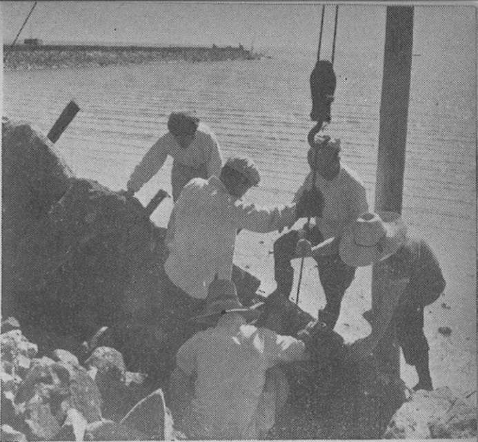
有明航送船に備えて長洲港の堤防工事
