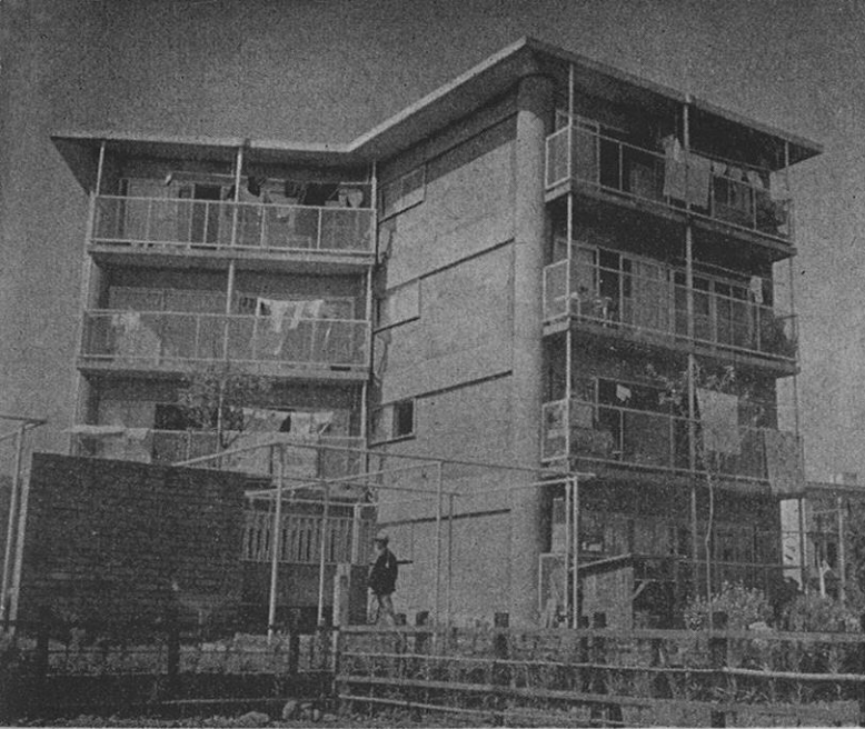
28年度Y型アパート 県下ではじめてのY型鉄筋アパートは敷地が少なくてすむからよい。間取りその他に色々新機軸を生み出している。風呂場がついているのもこのアパートだけ。ベランダの金網も細目のものを使用して危険を防ぐなど気を配っている。(全出水町堀の内団地)
