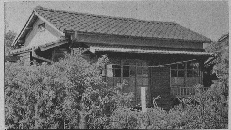
24年度 木造の1戸建 といえば当時にしては素晴らしい住宅であつた。健軍団地のもは2戸建。この頃まではまだ耐火建築ではなかつたが、翌年度から木造耐火建築が多くなつた。(全渡鹿団地)
