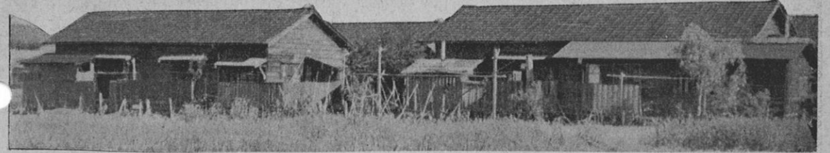
昭和22年度 終戦後の混乱時代、極度に不足していた住宅を何はともあれ「量」の面で解決しようとしたいわば県営住宅の第1号。(熊本市砂取団地)
