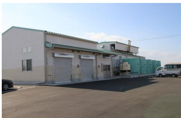
図2 (株)ARC の共乾施設（長洲町）
