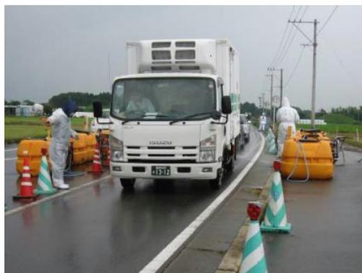
イ タイヤハウス、泥よけ、ホイール、タイヤの洗浄・消毒を行う。その際、タイヤの溝や側面については、入念に洗浄・消毒する。
