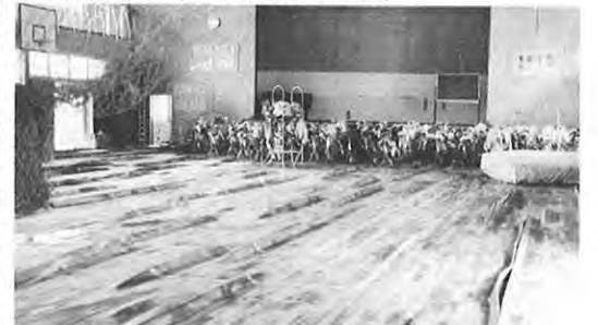
浸水により床板がめくれ上がり使用不能となった体育館(芦北町吉尾中学校)
