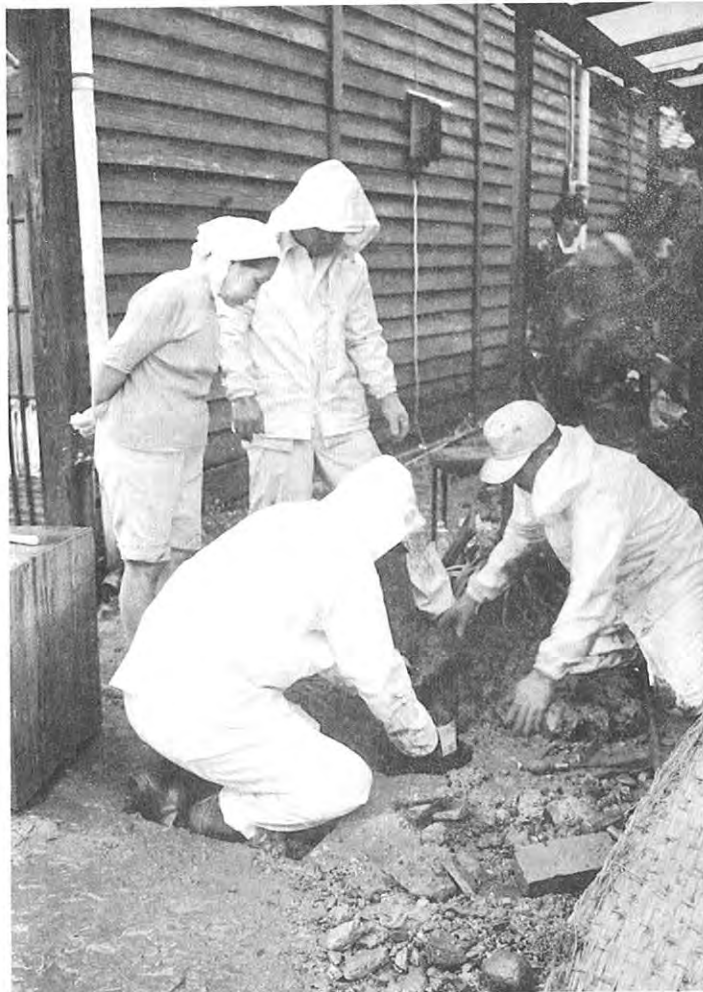
命の水、上水道の復旧工事（山鹿市）
