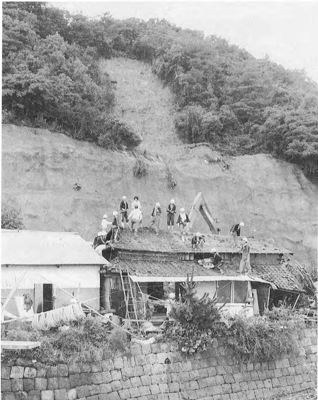
がけくずれの直撃を受けた家屋の復旧作業をする消防団員（不知火町）
