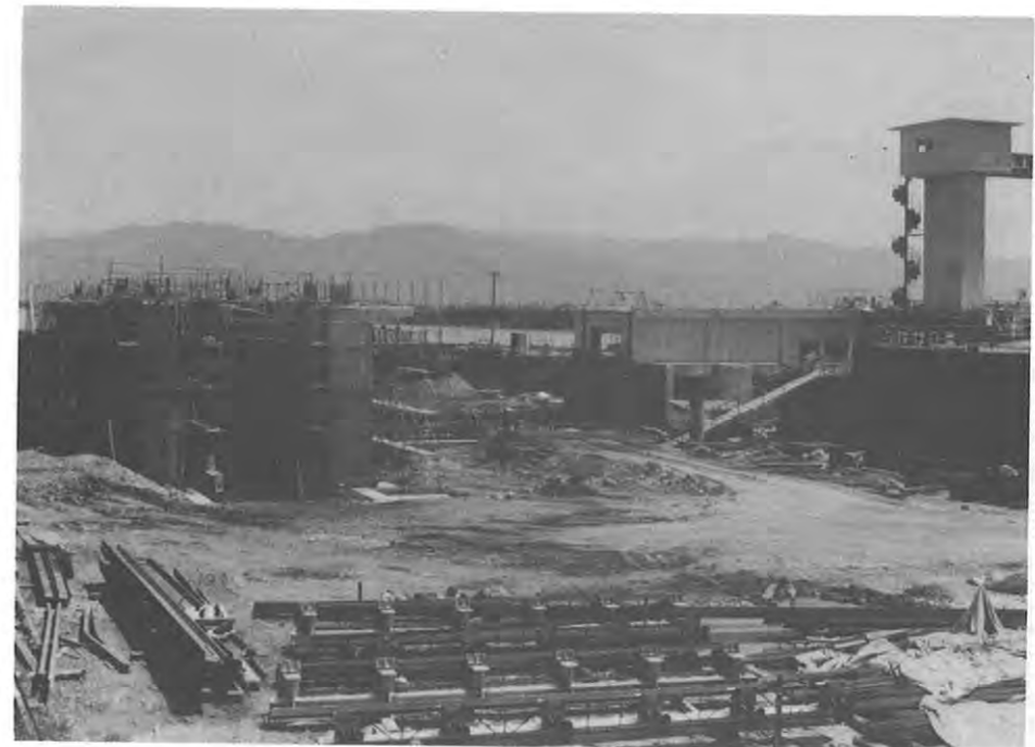
改築中の大榎樋門（八代市）
