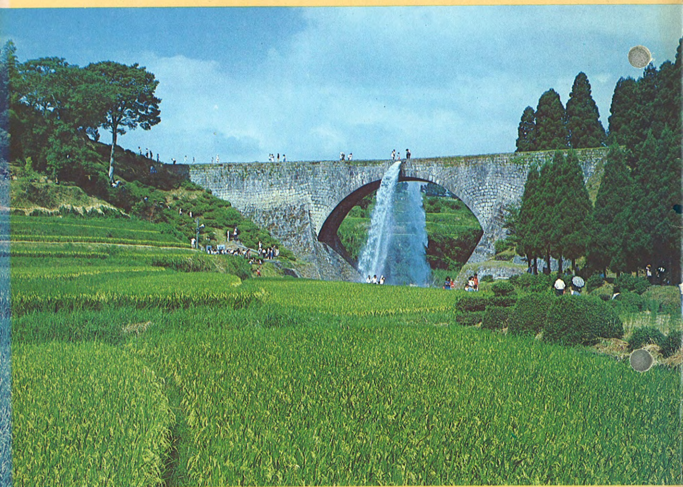
通潤橋(矢部町)
