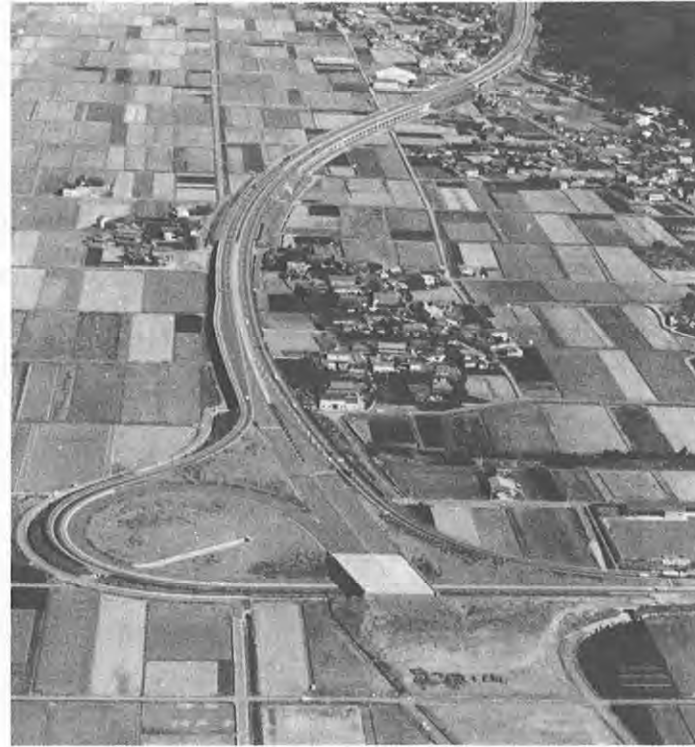
▲南進する九州縦貫自動車道(八代インターチェンジ)
