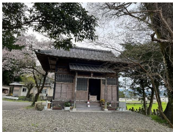
(令和7年3月30日・文化課) 復旧状況
