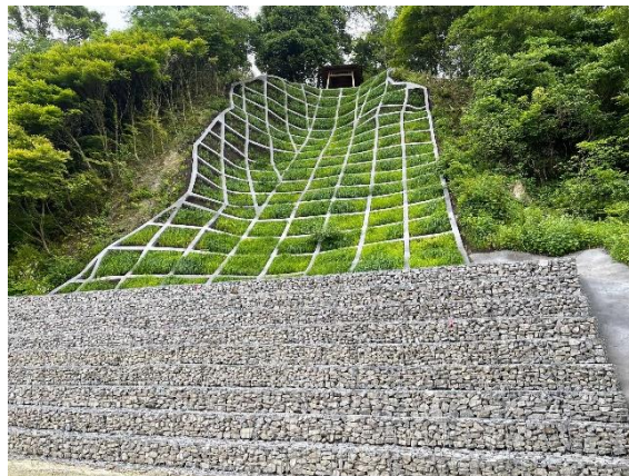
(令和4年6月9日・文化課) 復旧状況
