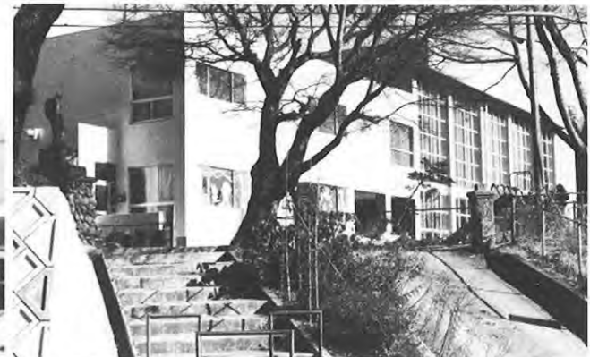
▲体育館を備える南部地区公民館
