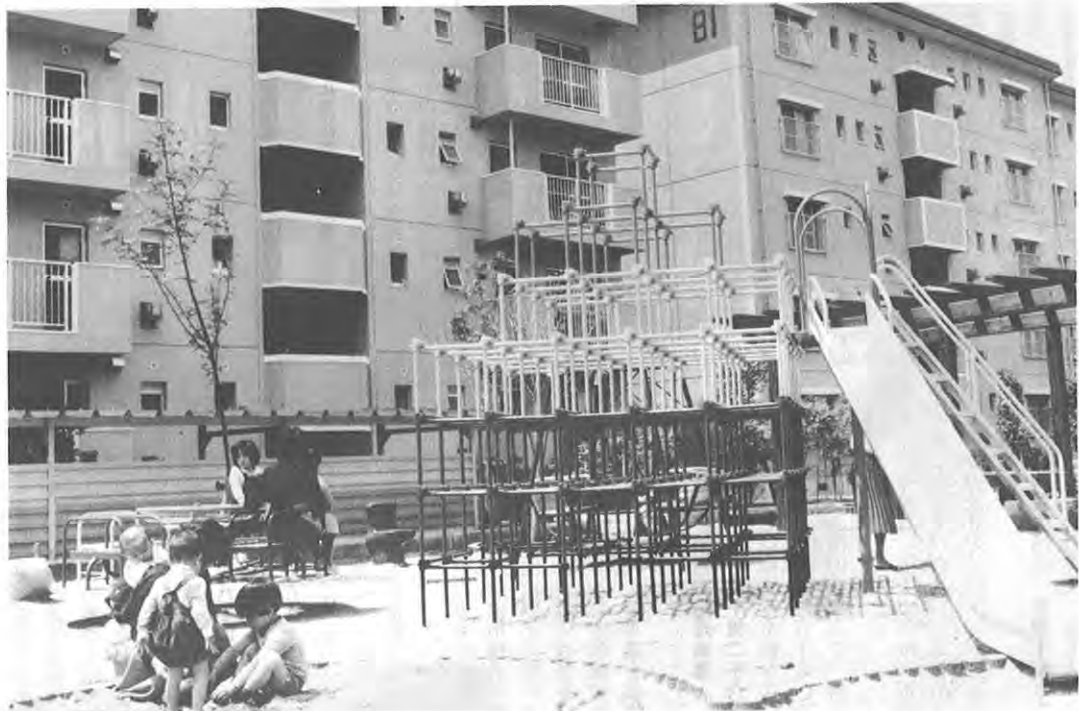
県営田崎団地
