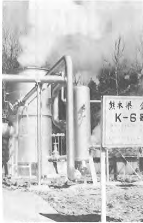
地熱発電調査井
