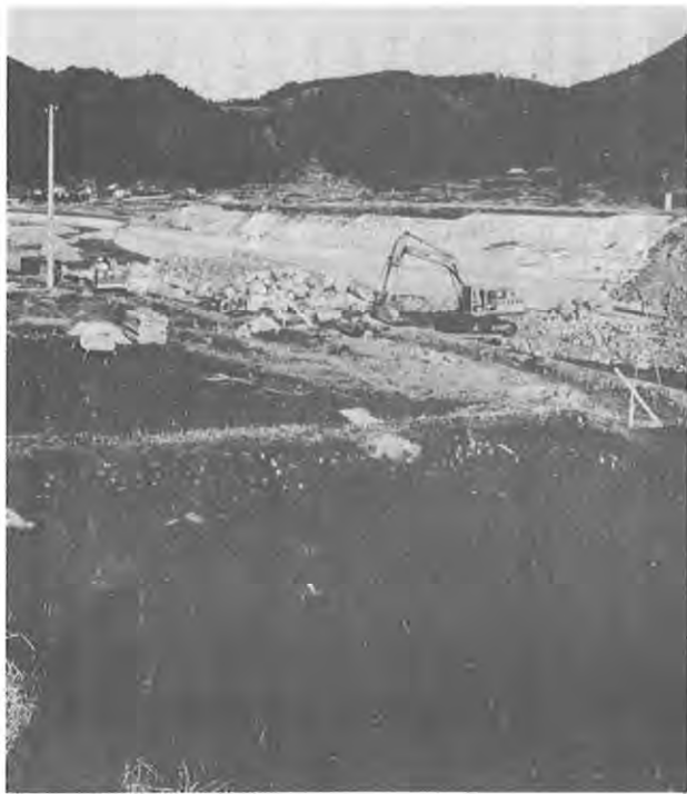
河川工事（人吉市）
