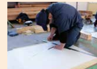
原寸図作成作業
