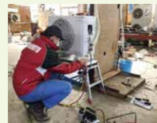
エアコン実習
