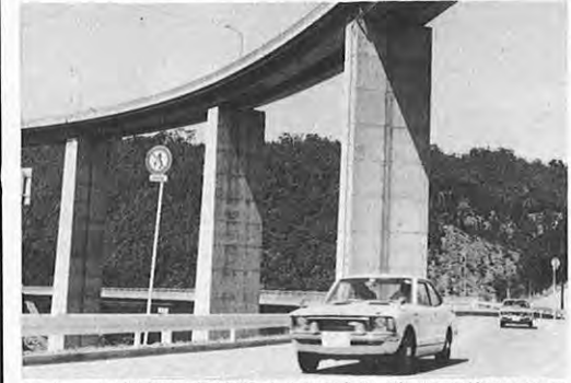
4.1—人吉市と宮崎県えびの市を結ぶ国道221号の改良工事のうち熊本県側の工事(19.7km)が完了した。161億を投じたループ橋の完成により、この区間の所要時間は1時間40分から50分に短縮された。総事業費183億円。
