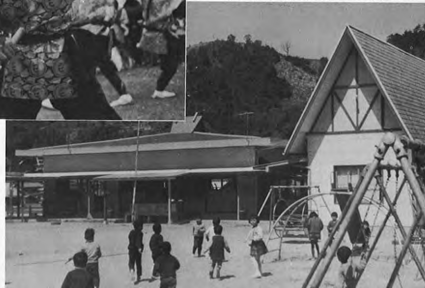
▼旧七ヶ村会部に建設された保育所
