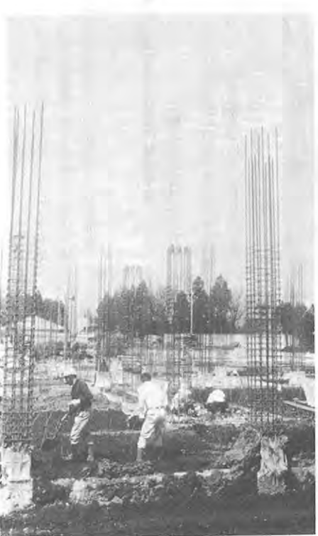
▲白水村に建設中のコミュニティセンター
