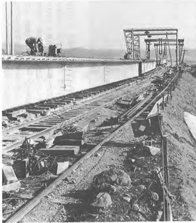
▲バイパス道路の橋りょう工事
