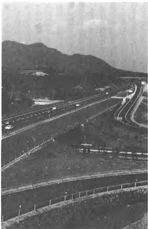
▲九州縦貫自動車道 (御船町付近)
