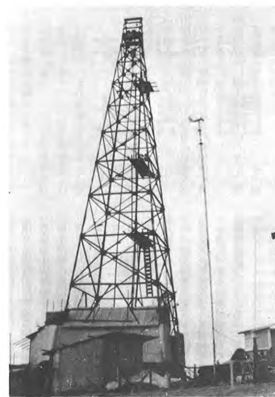
▲ボーリング調査風景
