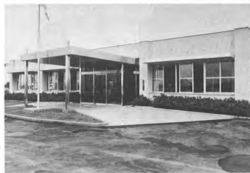
5.25—心身障害者の就職促進を目的とした、熊本身障者職業センターが熊本市長嶺町の旧空港跡にオープンしました。鉄筋コンクリート平屋建て、敷地面積1050㎡で建築費6千20万円
