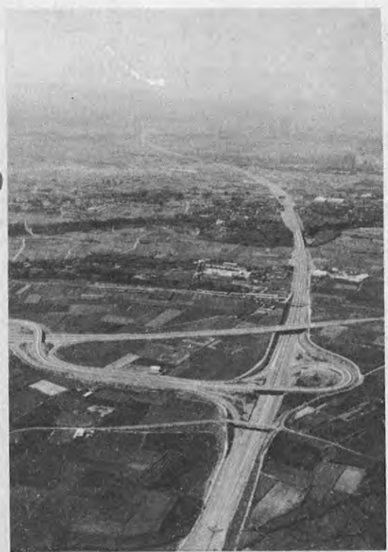
△九州を南北に貫く縦貫道
