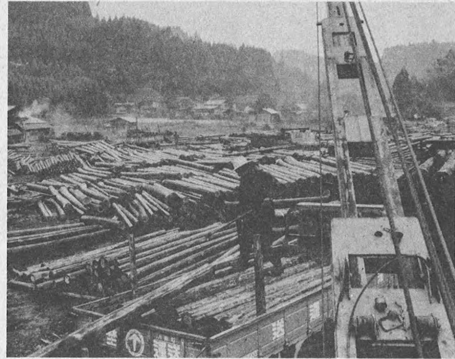
▲大型機械の導入により木材の搬出も進む
