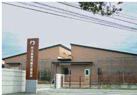
熊本県食肉衛生検査所 (R2.11 完成)
