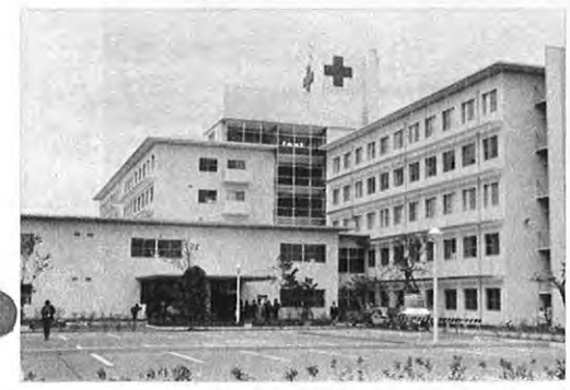
5.2-熊本赤十字病院の落成式が熊本市長嶺町龍蛇平の現地で行われました。敷地26,500㎡総工費27億円。
