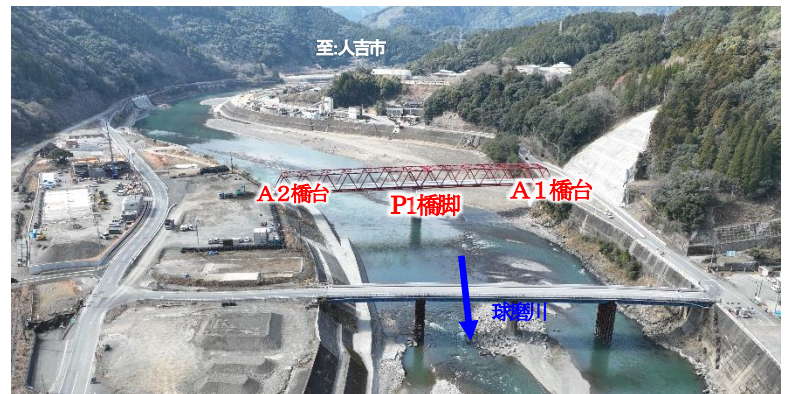
坂本橋施工状況 (令和7年3月)
