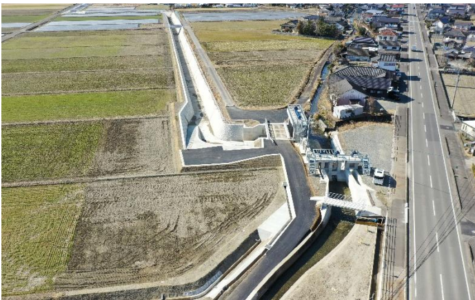
御溝川（人吉市）二次放水路整備
