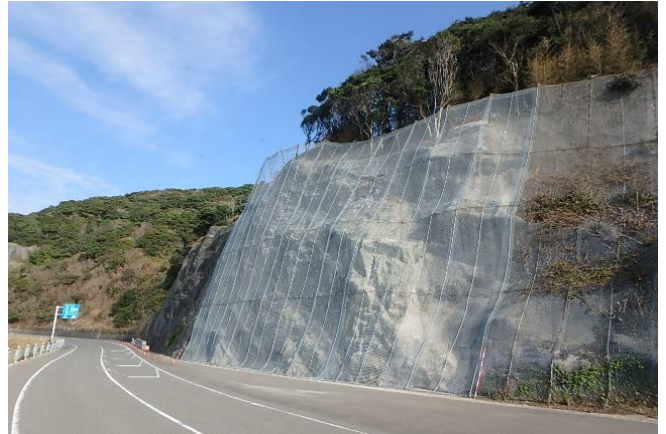
国道389号（天草市）落石防護網工
