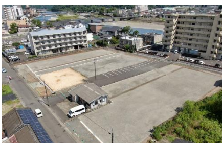
〔青井被災市街地復興土地区画整理事業における宅地造成工事の状況〕
