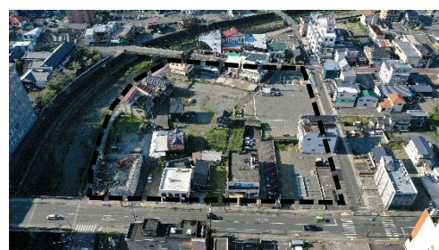
〔こうや紺屋町被災市街地復興土地区画整理事業における宅地造成工事の状況〕
