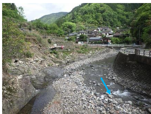
被害状況（令和2年7月時点）
