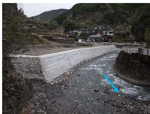
復旧状況（令和6年6月完了）
