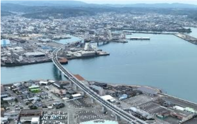
熊本天草幹線道路「本渡道路」
