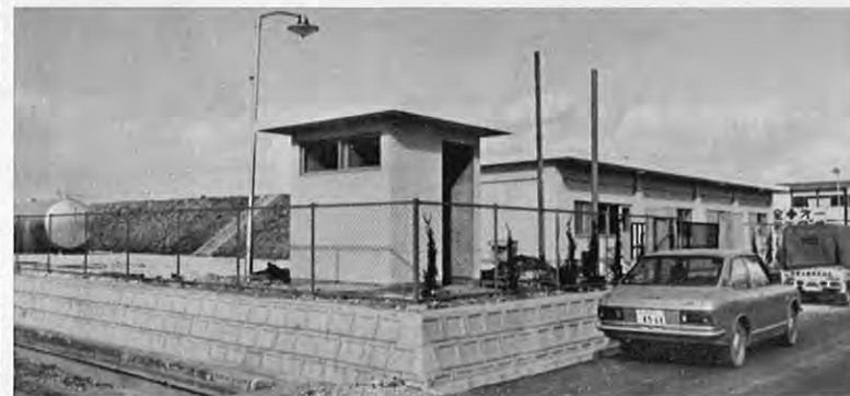
▲簡易水道浄水場
