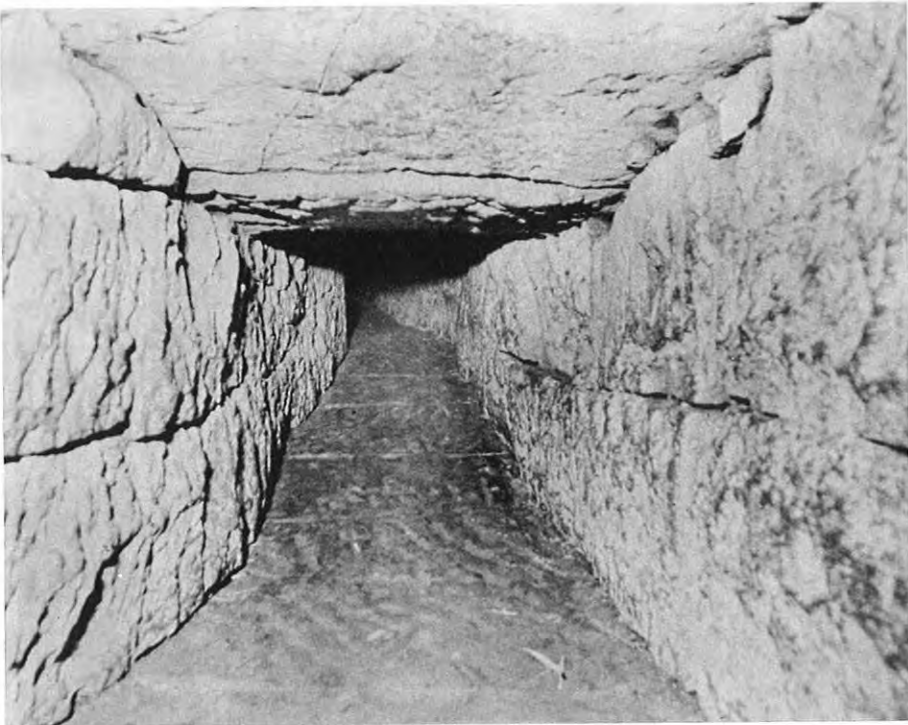
▲細い石積みのトンネル、幅50~60cm、高さ60~70cm 人がはって通れるほどの大きさ。
