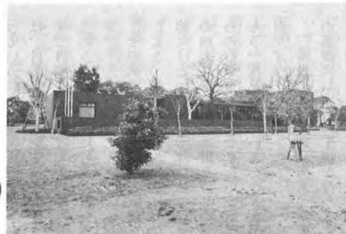
3.4—熊本城二の丸に県立美術館がオープンしました。地下一階、地上二階の総合美術館で、県内の代表的装飾古墳のレプリカを配した装飾古墳室を備えています。総工費11億9千2百万円。
