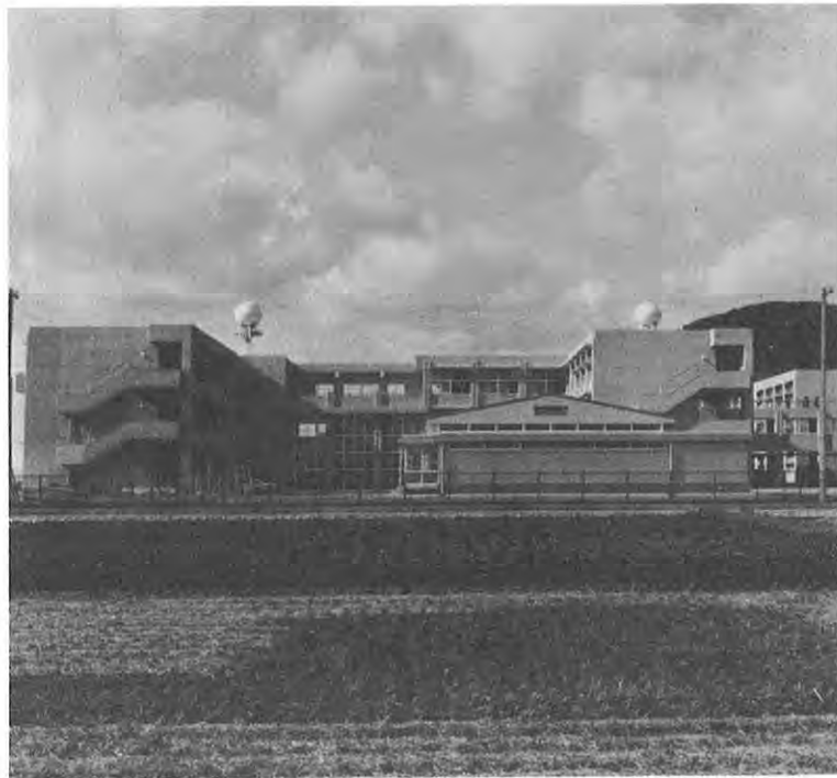
▲完成した熊本西高等学校
