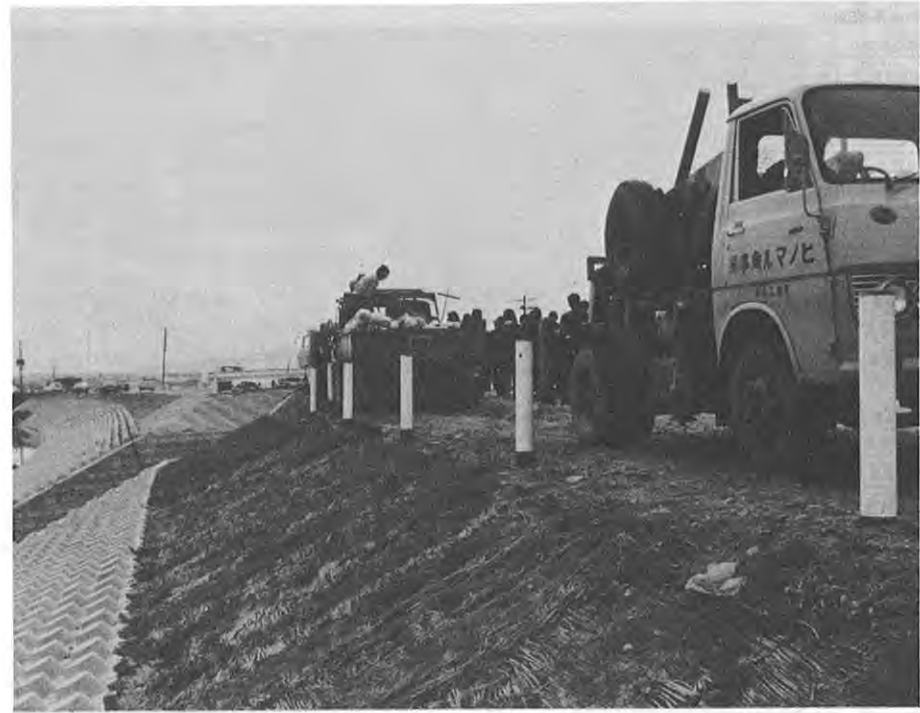
▲急ピッチで進む安全施設整備
