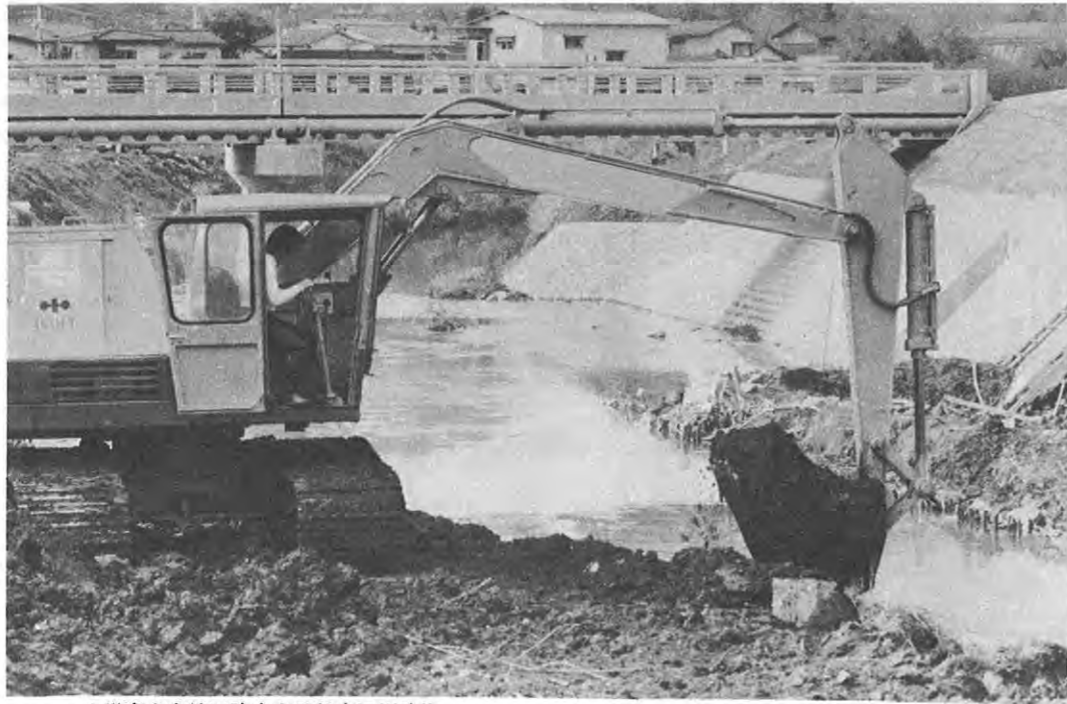
▲災害を未然に防止する都市河川改修
